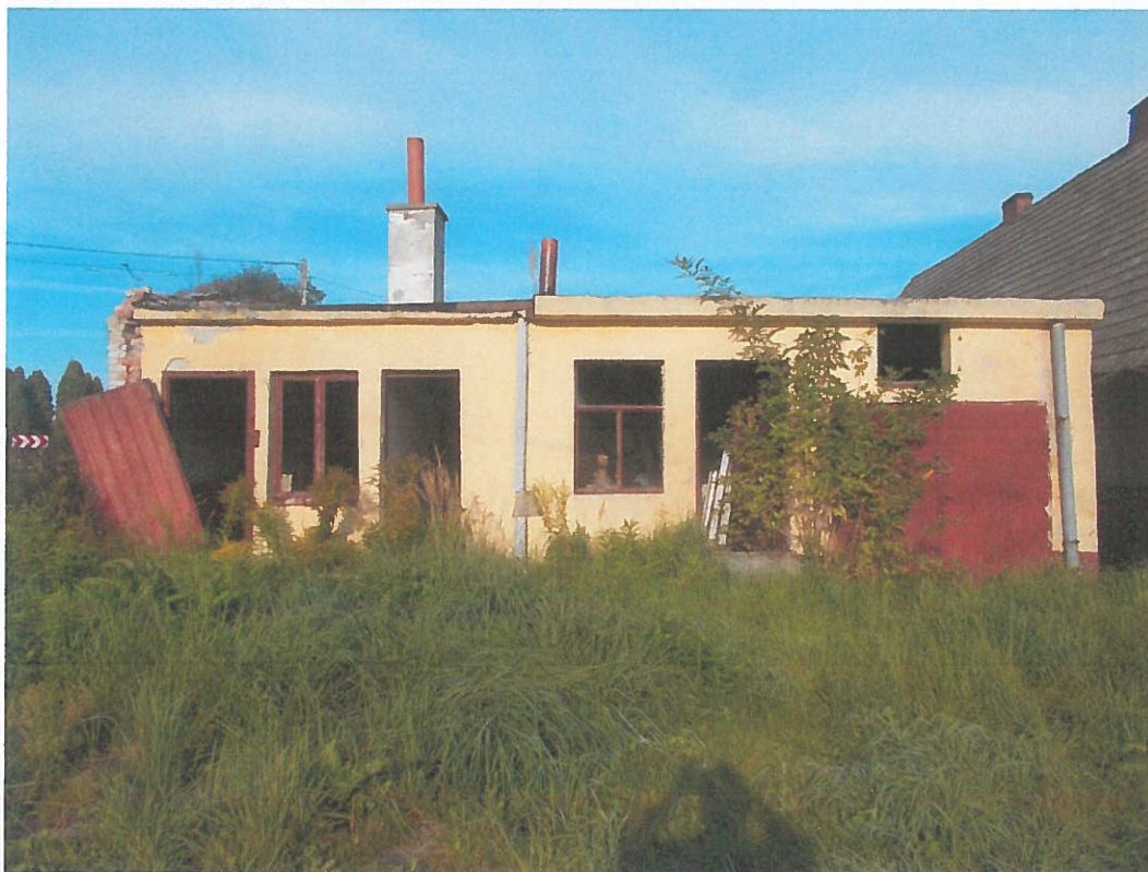
Fot. 1 Widok budynku warsztatowego od strony działki nr 3164.
