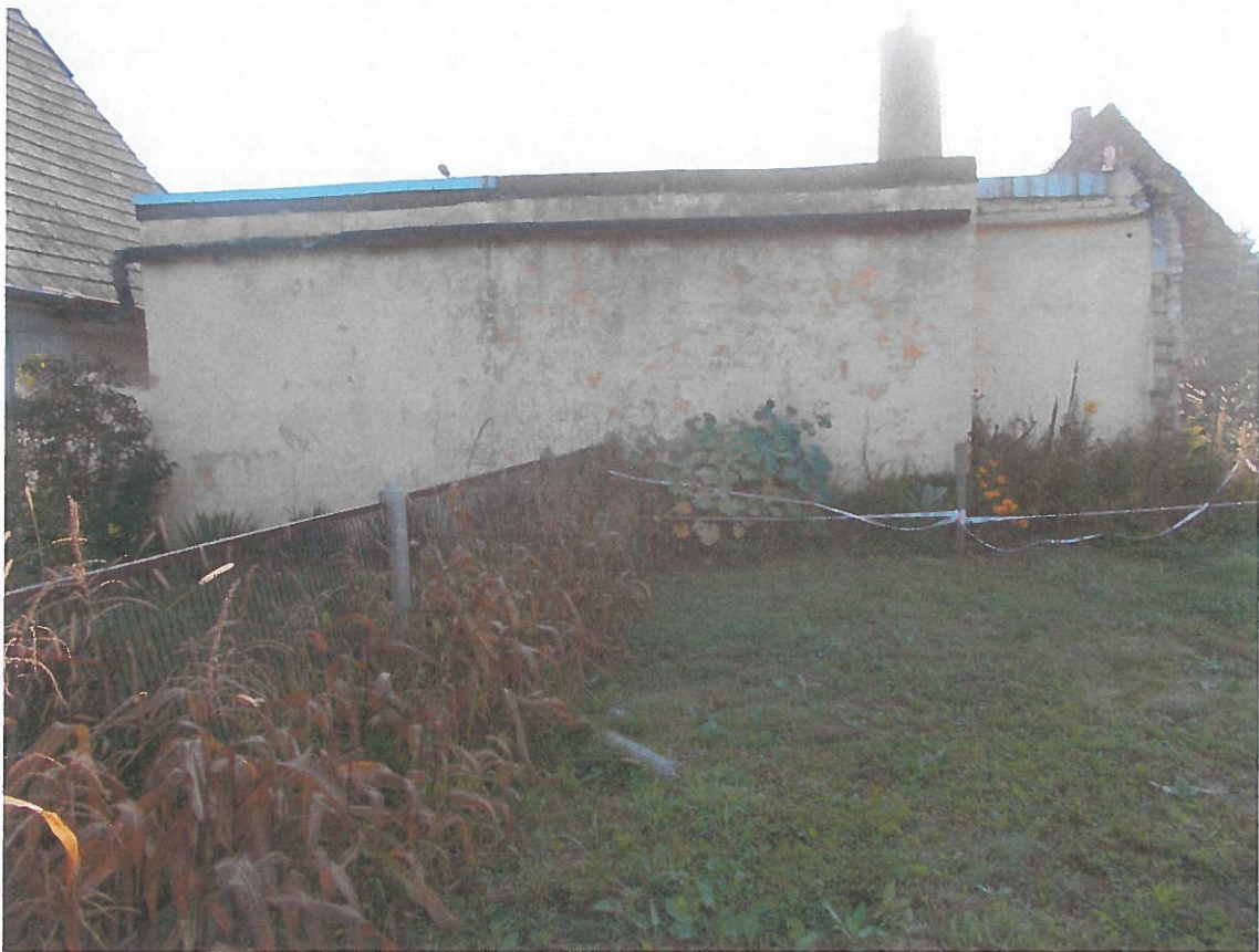
Fot. 3 Widok elewacji tylnej budynku warsztatowego.
