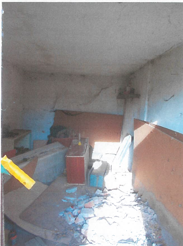
Fot. 5 Widok pomieszczenia magazynowego.
