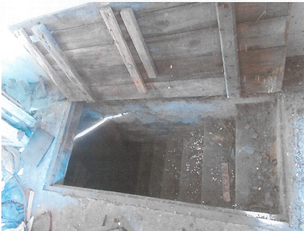
Fot. 6 Widok wejścia do piwnicy
